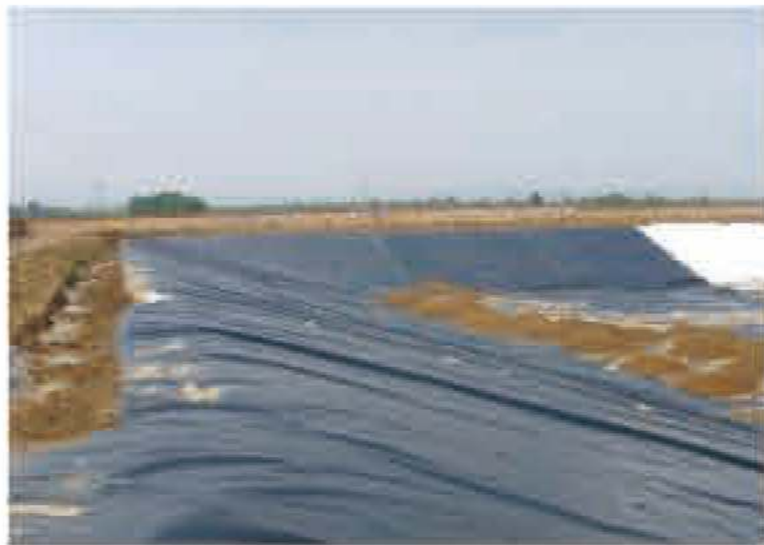
HDPE土工膜在山东平原污水处理场工程中的应用 Application of HDPE geomembrane in Shandong Plain sewage treatment works
