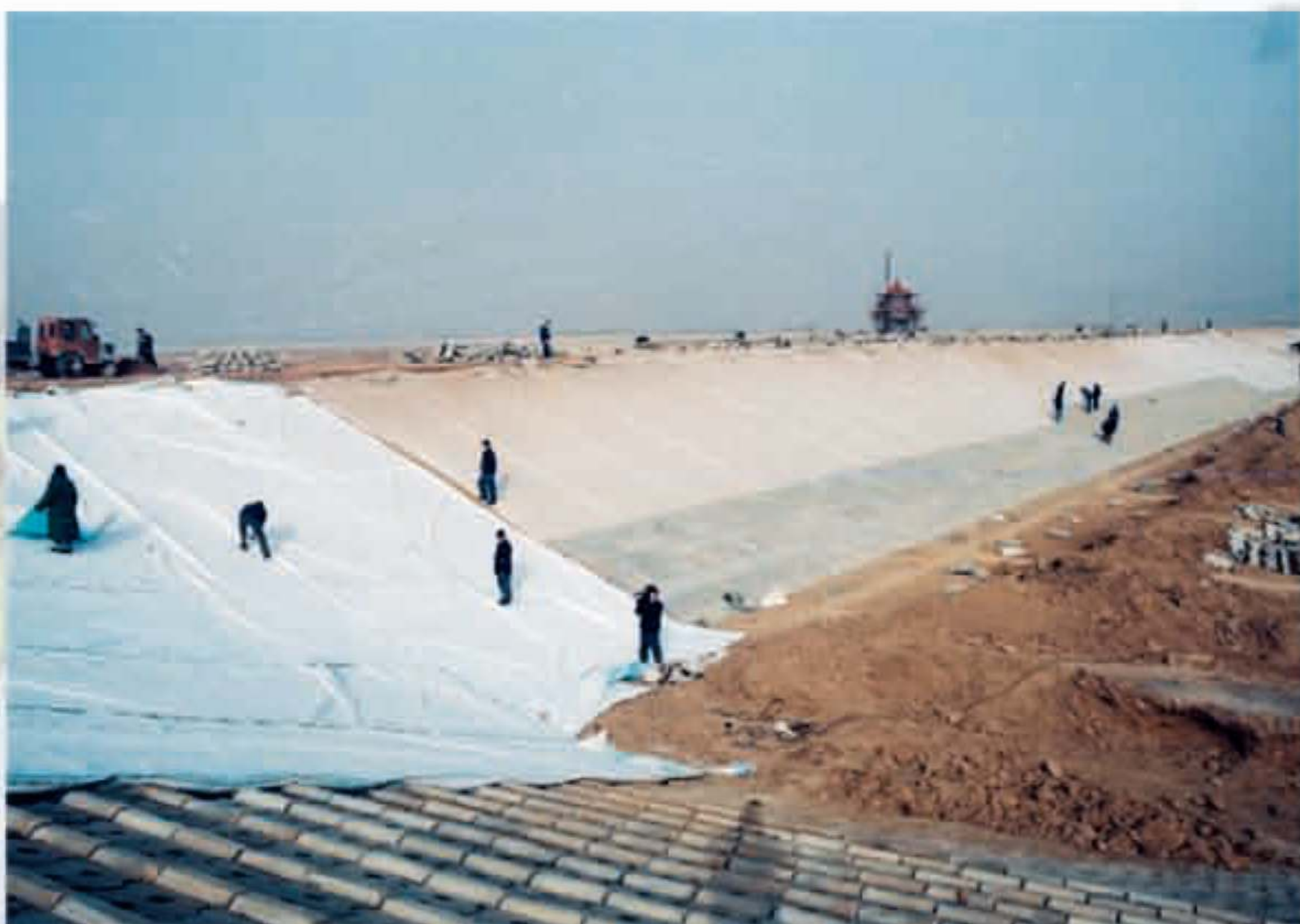
堤坝建设 Dam Construction
